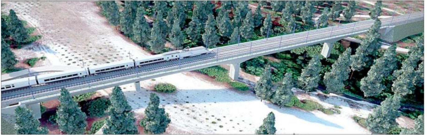
Viaducto sobre la Zona de Especial Conservación 'Riberas del Adaja y Afluentes', una de las estructuras que forman parte del proyecto. E. M.
